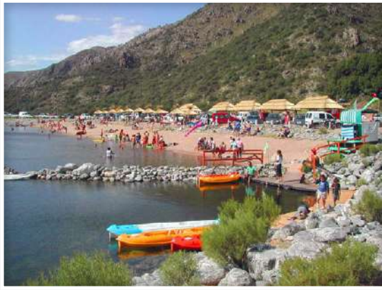
Dique Pisco Yaco - 10 Km
